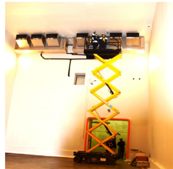
L'immagine ritrae le sequenze di verifica successive all'evento. Si notano la piattaforma utilizzata dal lavoratore e la zona delle bocchette di immissione dove il lavoratore si era recato per svolgere l'operazione di sostituzione del ventilatore
